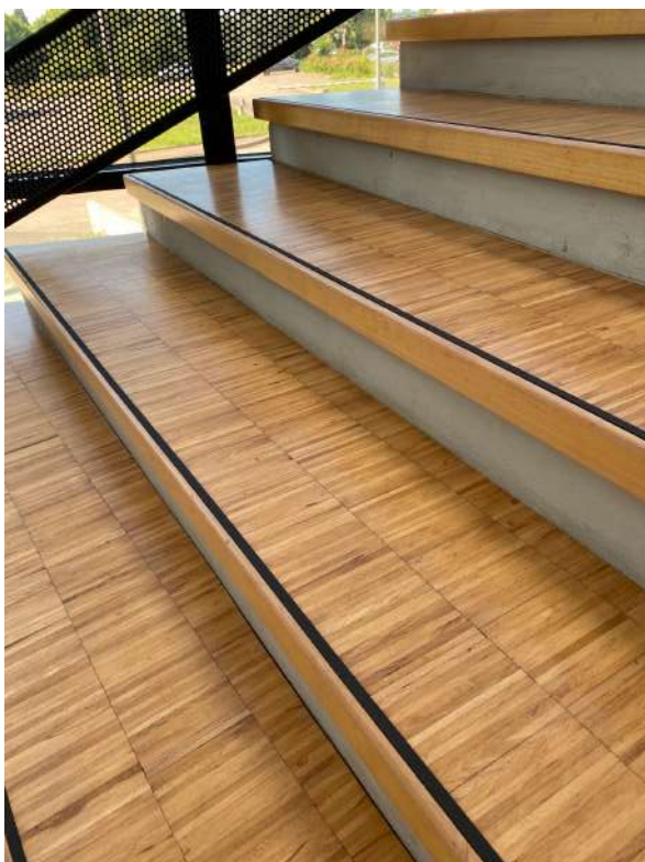
Rénovation de l'escalier en décembre
